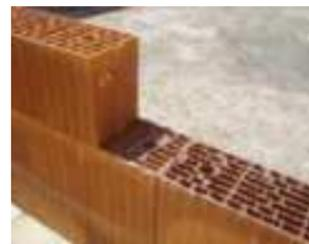
■ Maçonnerie brique de terre cuite isolante
