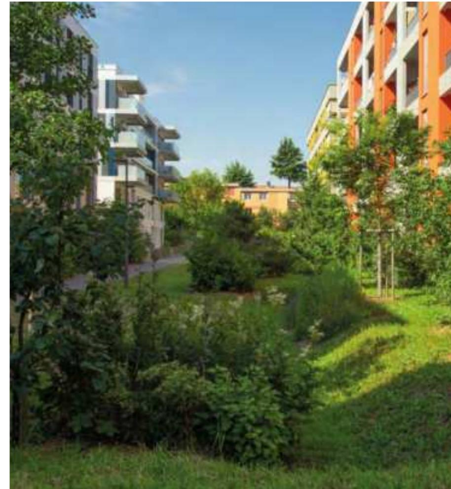
■ *■* **Noue centrale pour récupérer et infiltrer les eaux pluviales**
