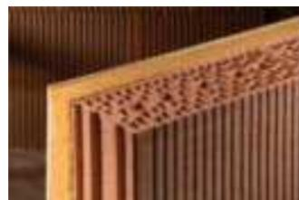
■ Doublage des murs en brique par 140mm de fibre de bois
