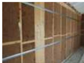
■ Isolation de l'ossature bois par fibre de bois entre montant. Un complément intérieur sera ensuite ajouté pour couper les ponts thermiques
